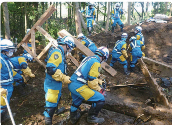
災害復旧の様子
