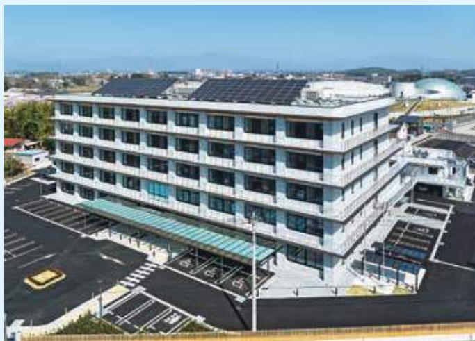
栃木県庁那須庁舎（大田原市）
