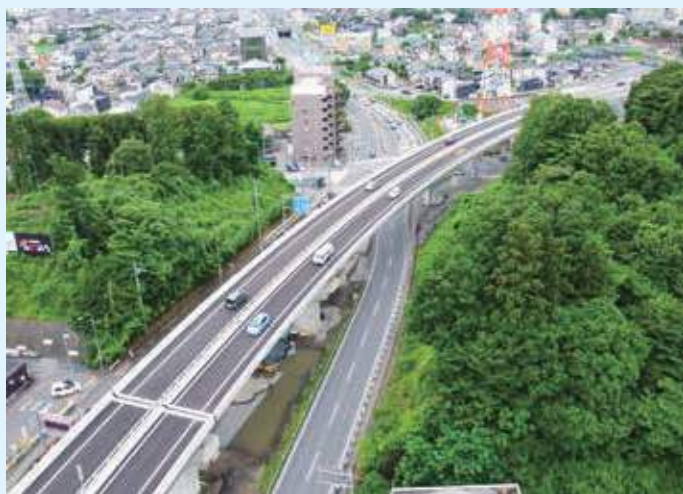
国道119号 上戸祭立体（宇都宮市）
