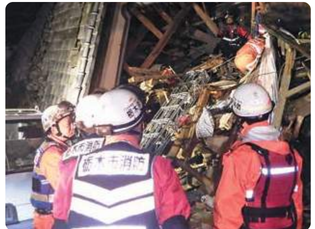
令和元年東日本台風の復旧作業
