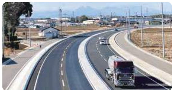
国道408号 真岡南バイパス (真岡市)
