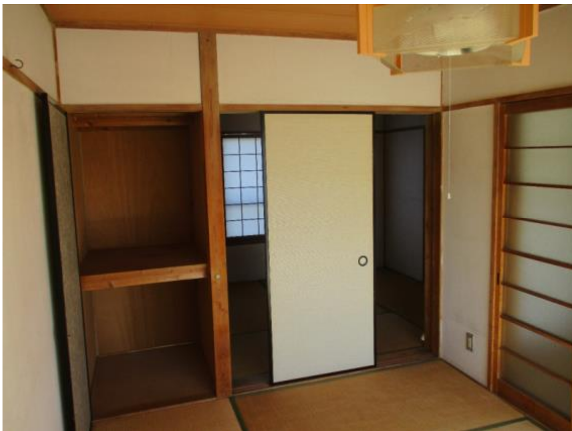
建物内にて撮影（居室）
