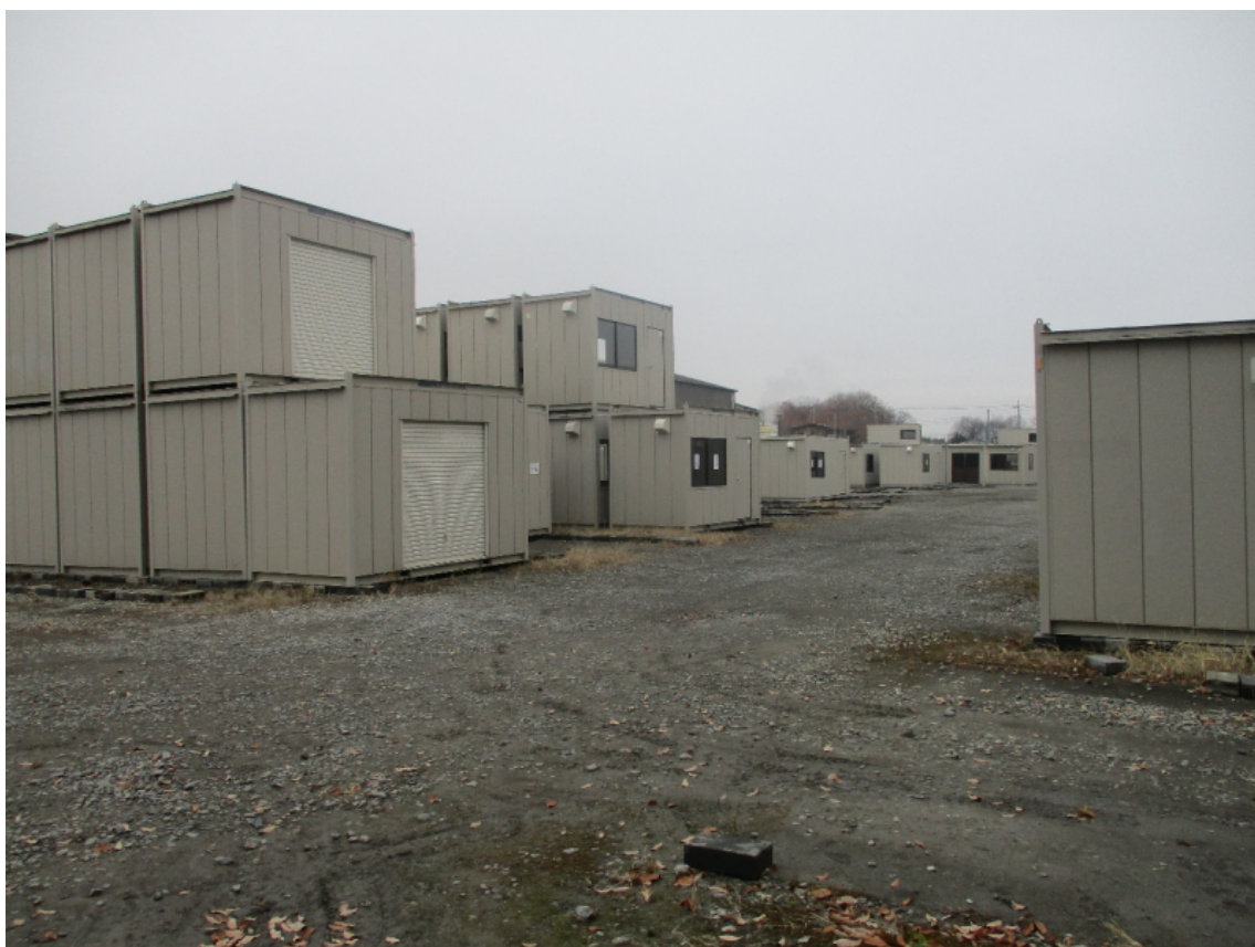
対象物件内の東側から西側を見て撮影
