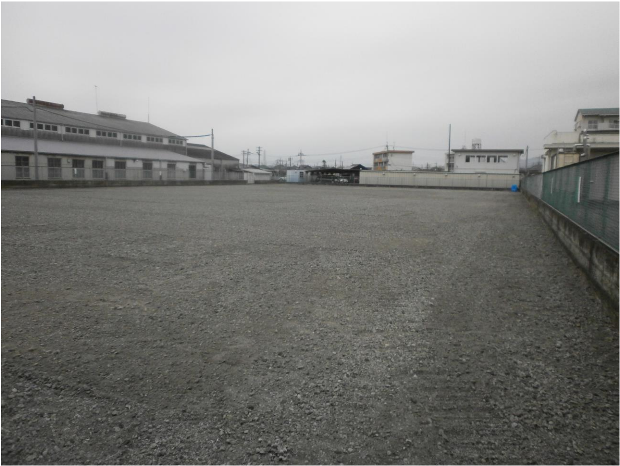
敷地北東から撮影
