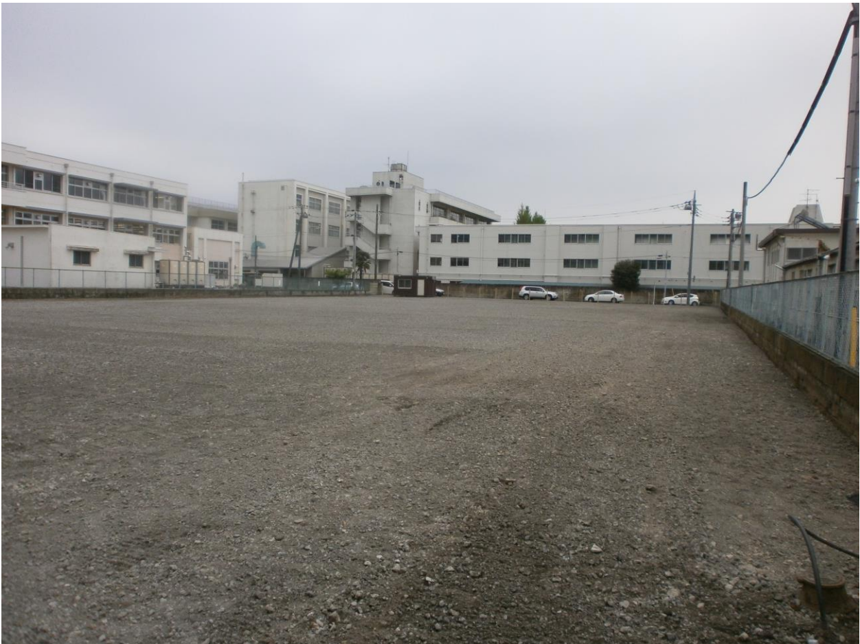
敷地南西から撮影
