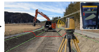
ICT建機の一例（操縦者をナビゲートするマシンガイダンス）
