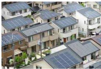
建物の断熱化・太陽光の設置
