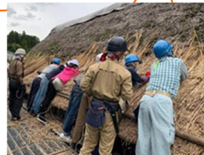
◀ 文化財保存・活用のための 茅葺き屋根修理の体験
