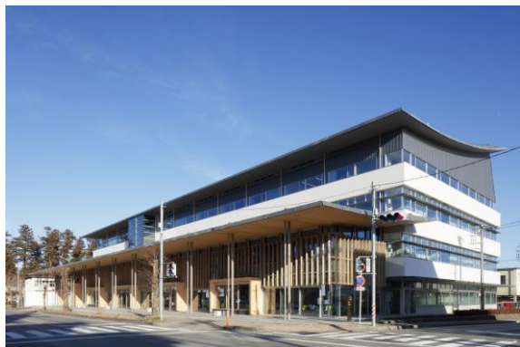
日光市役所本庁舎（日光市）
