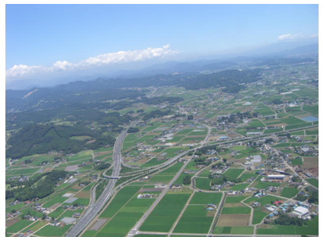
南北・東西軸を象徴する東北縦貫自動車道と北関東自動車道（都賀 JCT 付近）
