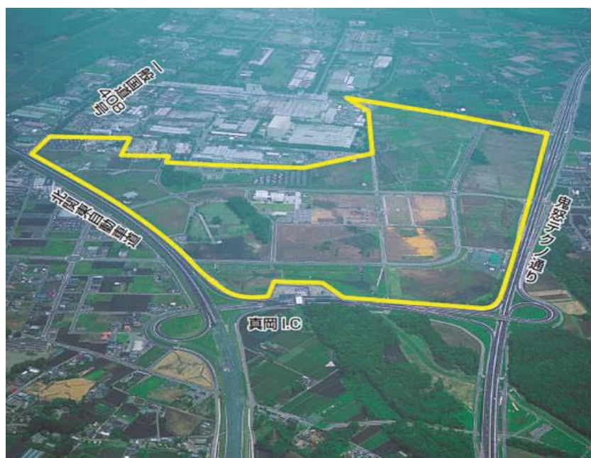
北関東自動車道から直結する工業団地 真岡第5工業団地
