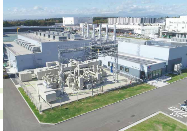
CO 2 排出削減に配慮した高効率なエネルギー供給施設
