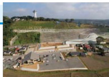
東日本大震災からの復旧 (さくら市倉ヶ崎地区)
