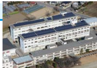
校舎の屋上を利用した太陽光発電
