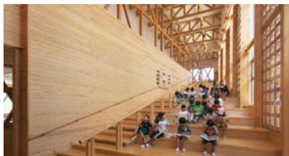
とちぎ材をふんだんに使用した小学校校舎
