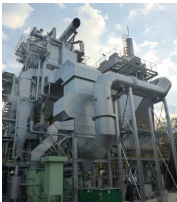
木質バイオマス発電所
