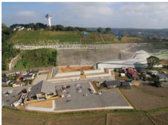
東日本大震災からの復旧(さくら市倉ヶ崎地区)
