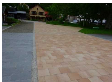
施工後「インターロッキングブロック」
