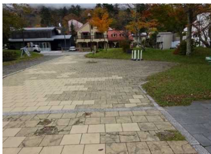
施工前「コンクリート平板」
